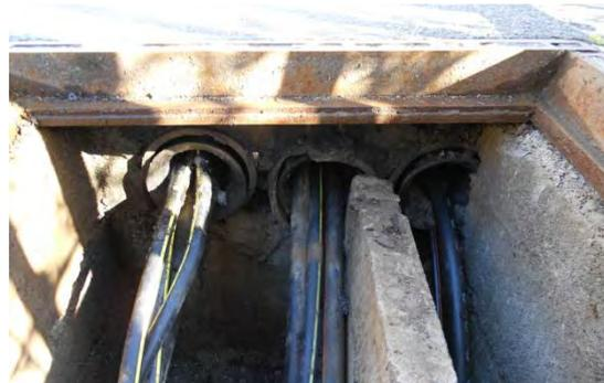
Abbildung 13 Einblick in Elektroschacht auf Trottoir
